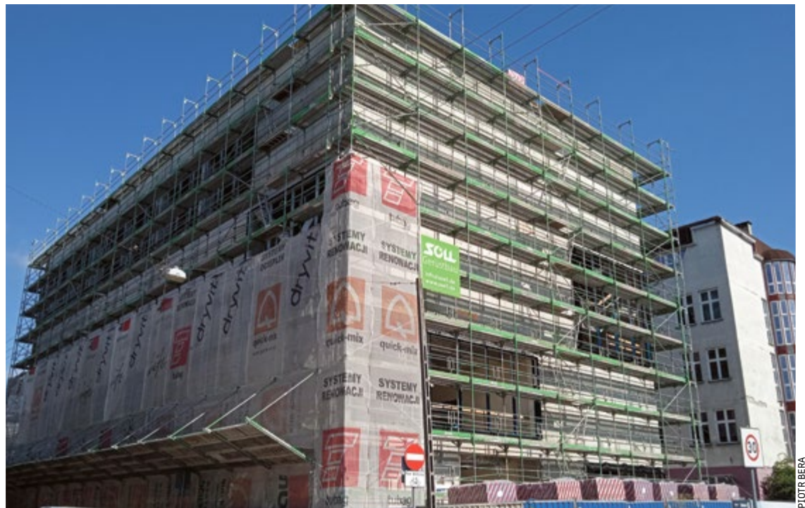
Obecnie trwa montaż stolarki okiennej oraz tynkowanie. Koszt całej inwestycji to 20 mln zł
